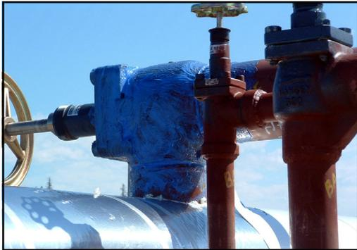
El **RG-2400® LT** es un gel de conversión de superficies que utiliza la tecnología de la mineralización “la ciencia de Minetics”. Este compuesto reemplaza el proceso de corrosión con una formación mineral dentro y sobre la superficie del metal que crea una barrera mineral de 50-200 angstrom de espesor.
